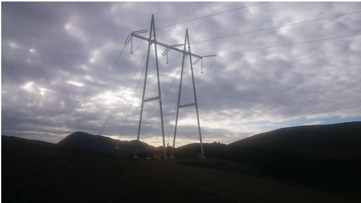
MYND 4.7 Frístandandi hornmastur sem kemur til greina að nota á nokkrum stöðum í línunni í stað stagaðra súluhorna. Myndin er af fastmastri, með jarðvísreyru, í Kröflulínu 4.
