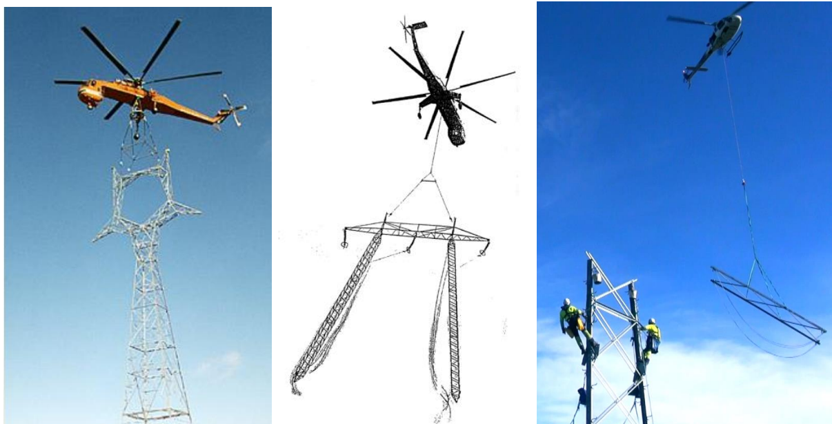
MYND 4.34 Reising masturs með Erickson þyrlu (lyftigera 11 tonn), mastur í stórum hlutum (til vinstri). Flutningur á 400 kV mastri í Svíþjóð (fyrir miðju). Reising hjá Statnett í Noregi, mastur hift í hlutum með lítilli þyrlu (lyftigeta um 1 tonn) (til hægri).
