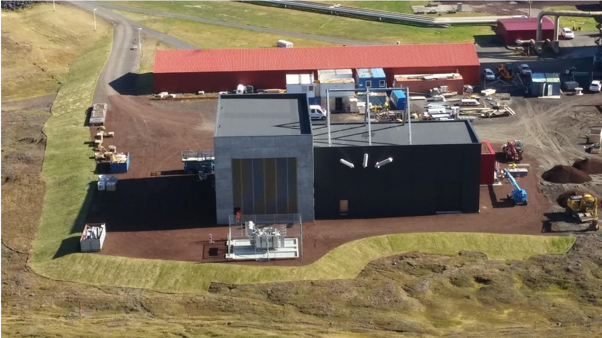
MYND 4.1 Nýja 220 kV tengivirkið við Kröflustöð. Inntak Kröflulínu 4 í stálramma á þaki. Nýtt tengivirki á Hólasandi og viðbót við tengivirkið á Rangárvöllum gætu lítið svipað út.
