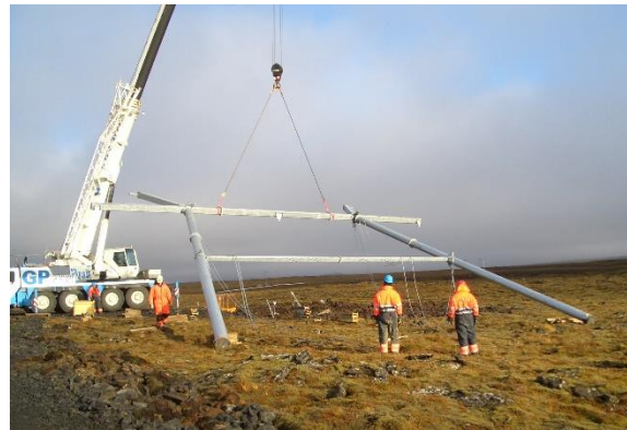
MYND 4.10 Myndir sýna vinnu við samsetningu og reisingu stagaðs burðarmasturs af M-gerð með jarðvírseyrum. Myndirnar eru frá byggingu Reykjaneslínu 1.
