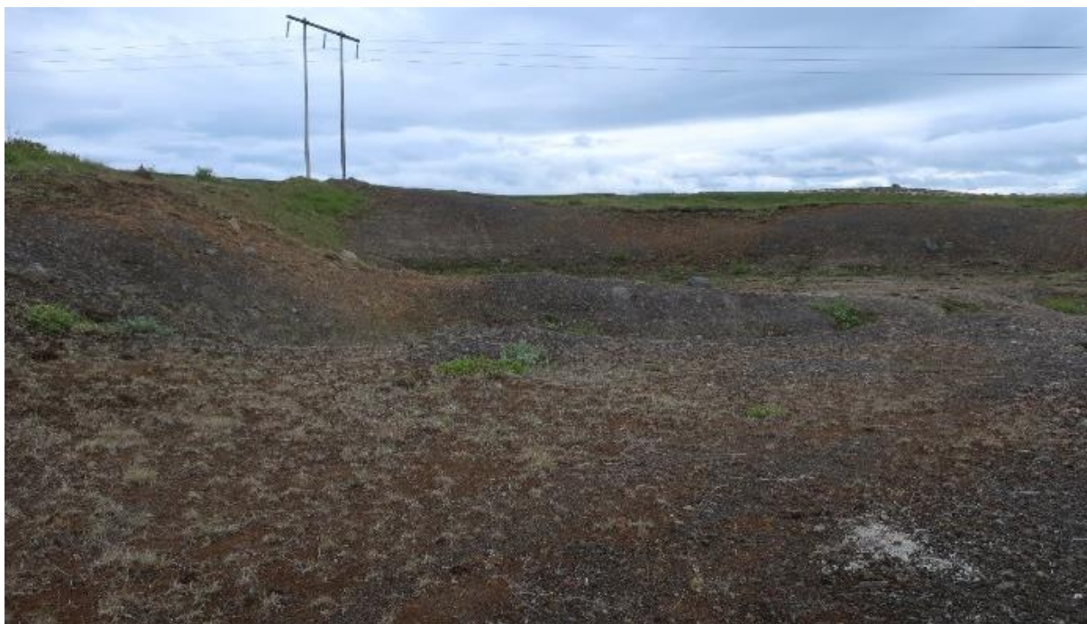
MYND 4.52 Kröflulína 1, fyrsta mastur neðan Þjóðveggar 1. og gamalt efnistökusvæði við afleggjara að Víðum.
