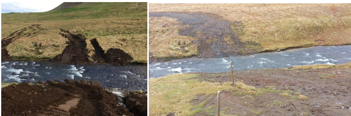
MYND 4.24 Dæmi um árpverun Fossár við Ólafsvík á Snæfellsnesi. Fyrri myndin er tekin í maílok 2017 þegar nýbúið er að leggja rör í árbotninn, en seinni myndin í byrjun nóvember 2017. Hún sýnir frágang eftir að 66 kV strengur hefur verið lagður og búið að slétta yfirborð, en 220 kV strenglöggn er talsvert umfangsmeiri.
